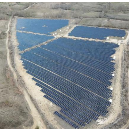
Projet Bouvreuil Opérationnel 2,2 MWc
