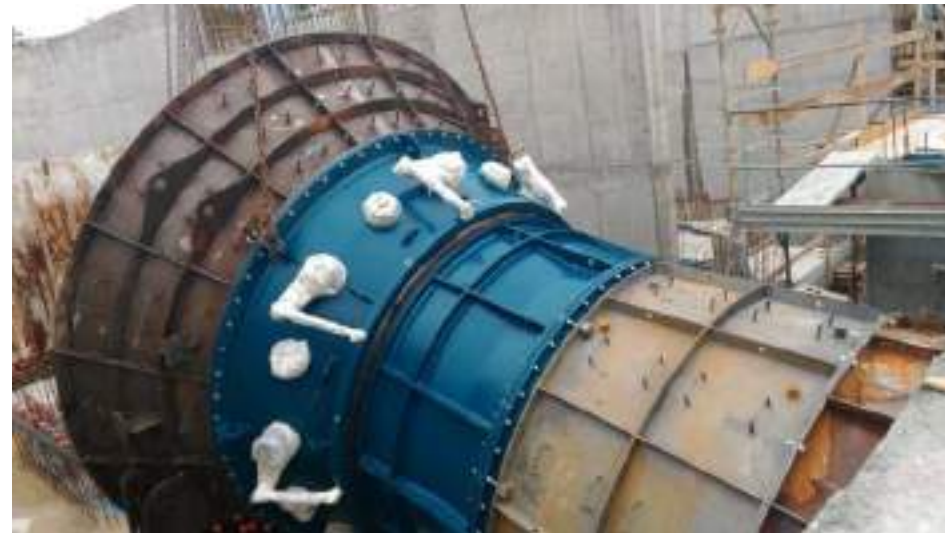
Cône d'entrée - distributeur - manteau de roue aspirateur installés
