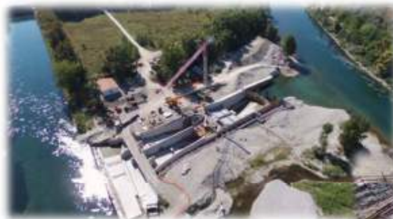
Vue générale du chantier
