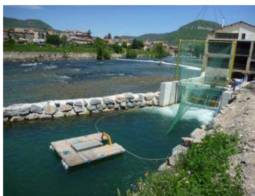
Plateforme de repêche
