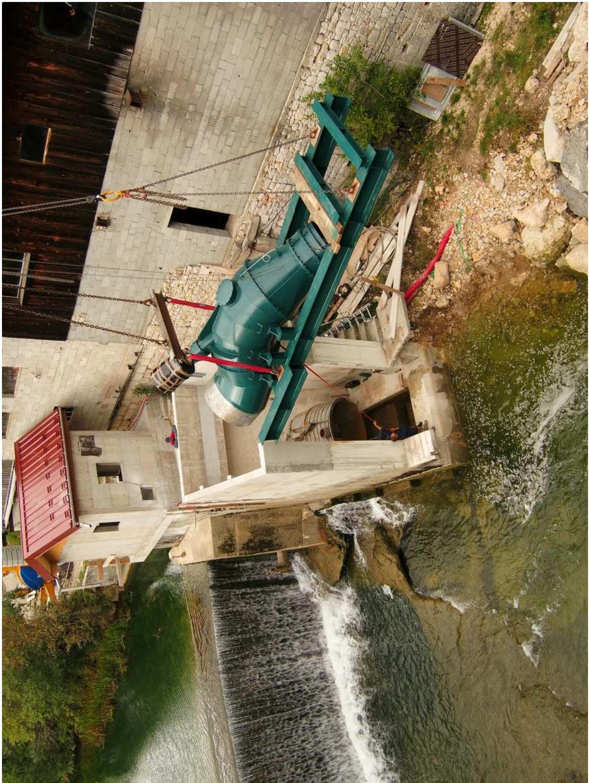
**Les Vis nécessitent un génie civil simple, pouvant être fortement réduit en fonction des solutions.**
