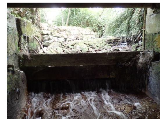
Vue du batardeau
